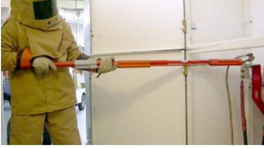
Şekil 8: Bu resimde görüldüğü gibi topraklama yapılırken özellikle ark değerine göre giyinilmeli.
