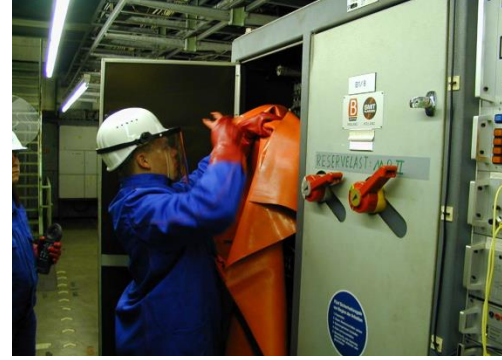
Şekil 10: Canlı hattın izole edilmesi
