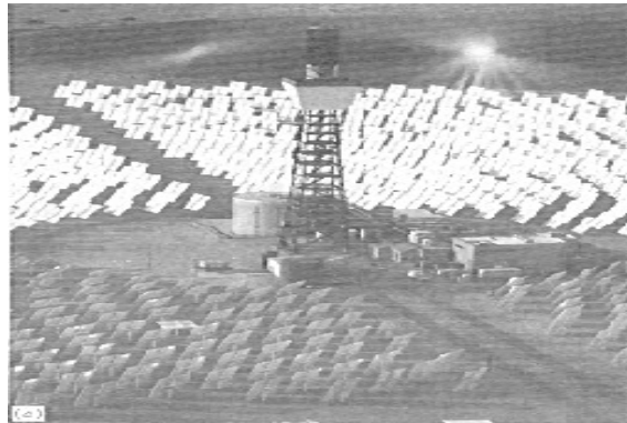
Şekil 1. Heliostat alanı ve alıcı kulesi üzerinden görünüş (sistem çalışmazken)
