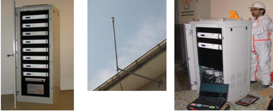
Resim 1. Güç Kalitesi Monitörlerinin Saha Montajı
