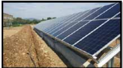
Panel ve Kablo montajı
