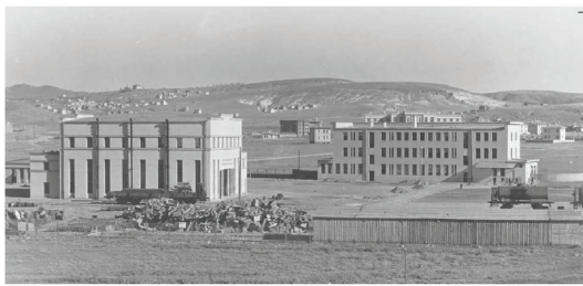
Ankara-Maltepe'de inşa edilen Elektrik ve Havagazı Fabrikası'nın 1930'lu yıllardaki görünümü, (Güzide Erkuş, "Ankara'da İlk Elektrik Enerjisi," TMMOB Elektrik Mühendisleri Odası Ankara Şubesi Haber Bülteni, Sayı 2009/4, s. 9. http://www.emo.org.tr/ekler/87b445317c480b3_ek.pdf?dergi=570 -Erişim Tarihi:13.11.2013)
