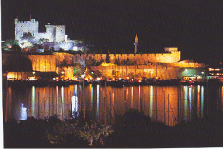
Resim 7. Bodrum Kalesinde Yapılan Dış Aydınlatma Uygulama Örneği
