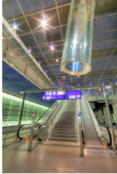
Şekil 18: Gün ışığının ışık tüpü ile taşınmasına bir örnek (Berlin)
