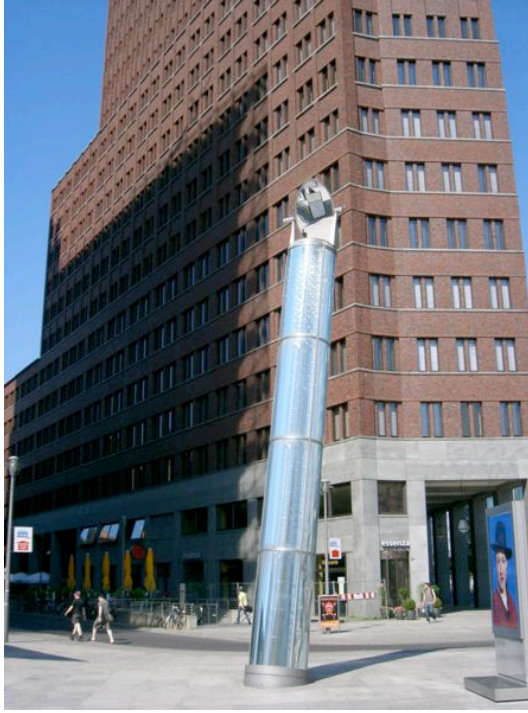
Şekil 18: Gün ışığının ışık tüpü ile taşınmasına bir örnek (Berlin)
