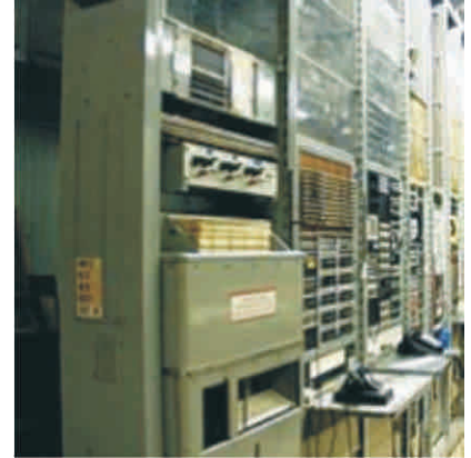
Krosbar Santral Arıza Kaydedici ve Master Test Frame
