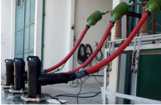
Şekil 4. Plug-in buşing ile bağlantı
