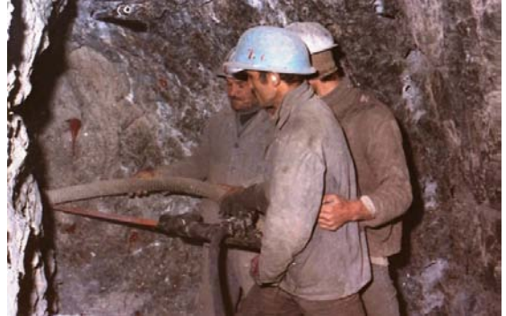
Foto 4. Artvin Barajı Galeri Çalı maları
