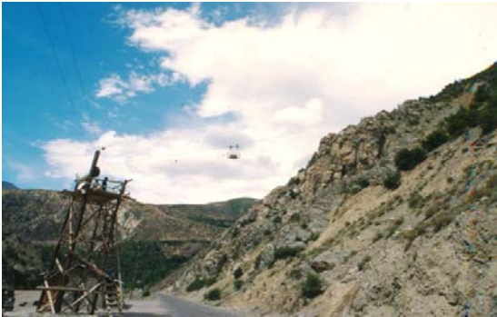
Foto 11. Deriner Barajı Sondaj Çalışmaları
