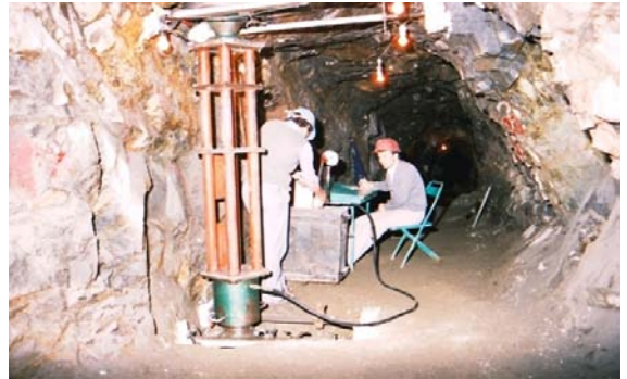
Foto 6. Güllüba Barajı Galeri ç i Kriko Deneyi
