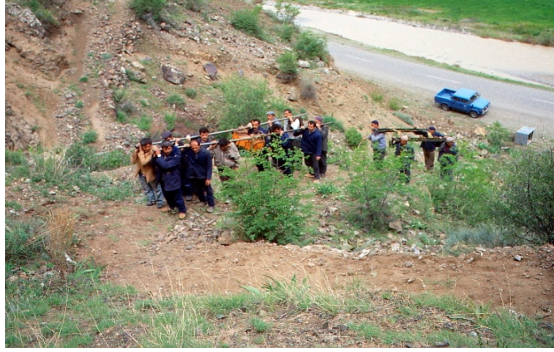
Foto 3. Ayvalı Barajı Sondaj Çalı maları
