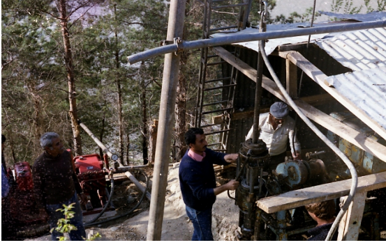
Foto 7. Deriner Barajı Sondaj Çalışması
