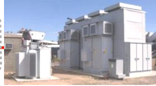
Enerji depolama – B.E.S.S.
