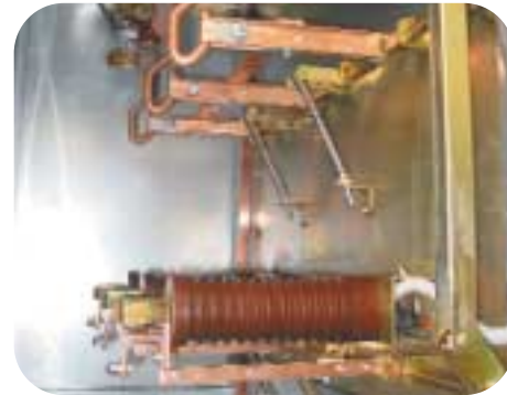
ESH36/2 – 36kV 1kA kısa devre üzerine kapama yapabilen topraklama ayırıcıları
