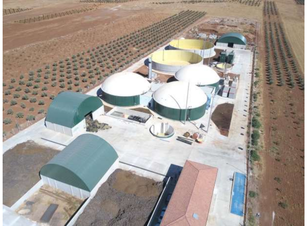
OĞUZELİ BİYOGAZ ENERJİ SANTRALİ 2 x 499 kW
