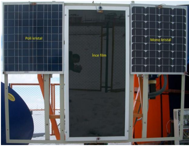
Şekil 1: Sabit Platform üzerinde güneş panellerinin görünümü
