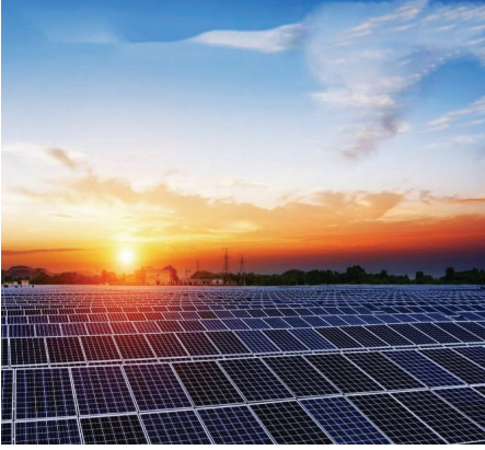
Güneş Elektrik santrali (GES)
