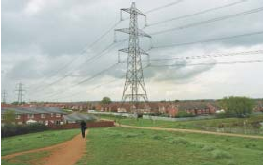
Şekil 3. İngiltere'deki 275 kV ve 400 kV'luk Enerji İletim Hatlarından Bazı Resimler
