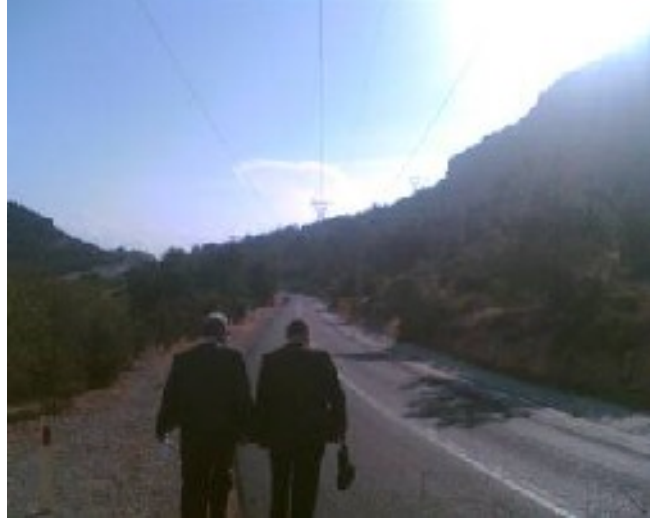
Şekil 23. St. Hilarion Yolu Boğaz Piknik Alanı Mevkii'deki 132 kV'luk Enerji İletim Hattının Resimleri
