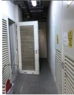
Otopark Alanına Açık Menfezli Jeneratör ve Pompa Dairesi Kapıları
