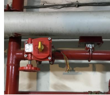
Kapalı Konumda Bulunan, İzleme Kabloları Panele Bağlanmamış Kat Giriş Vanası.
