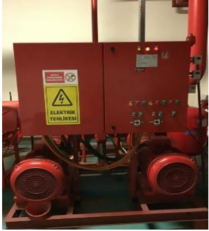
Onaysız ve Kapasitesi Yetersiz Yangın Pompaları
