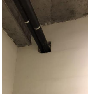
Tadilat Sonrası Yangına Dayanıklı Olarak Kapatılmayan Şaft Duvarı.
