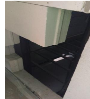
Şafta Ulaşım İçin Kırılan, Daha Sonra Tekrar Kapatılmayan Şaft Duvarı.
