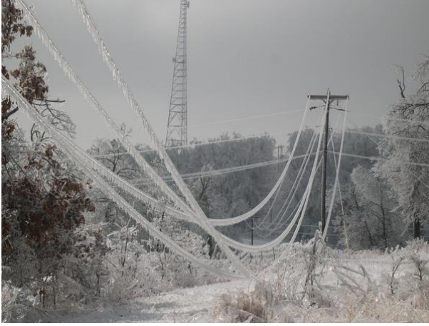
Görsel 8: Buz Yükünün Fazlalığının Enerji Nakil Elemanları Üzerindeki Etkileri
