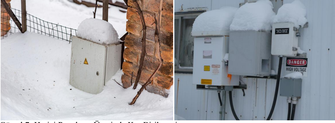
Görsel 7: Harici Panoların Üzerinde Kar Birikmesi
