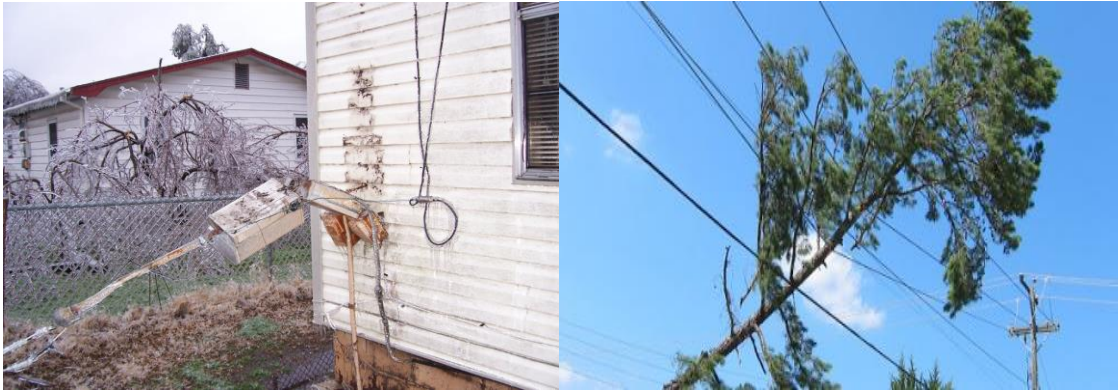
Görsel 1. Yatay Düzlemde Maksimum Yaklaşma Mesafesine Uyulmaması Durumunda Yaşanabilen Durumlar
