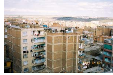
Resim 15 Sur İçinin Kuzeydoğu Görünümü
