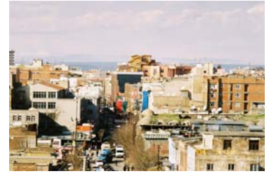
Resim 18 Sur İçinin Kuzeydoğu Görünümü
