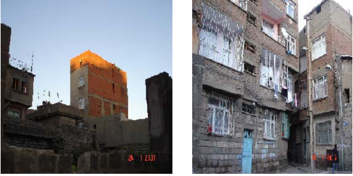
Şekil 5. Suriçinde Çarpık Kentleşme
