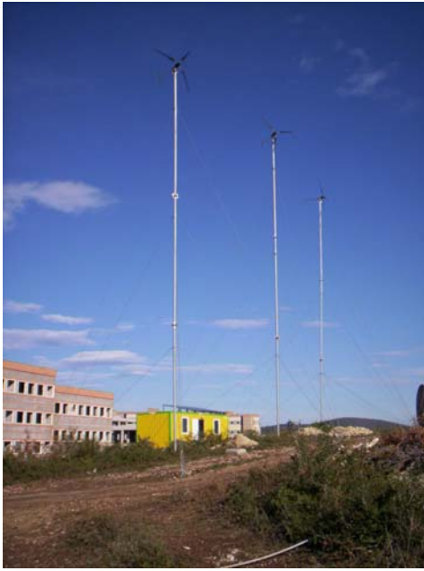
Şekil 3. Umuttepe Rüzgar-Güneş sistemi
