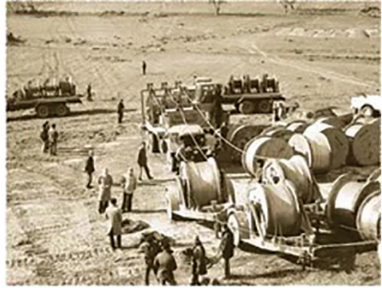
Elektrik hatlarının çekilmesi
