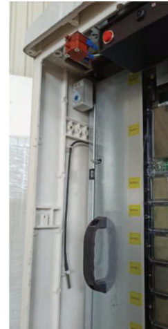
Şekil 3: Akıllı Pano İç Yapısında Sensör Entegrasyonu.
