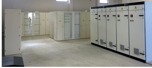
ALÇAK GERİLİM, OTOMASYON, MCC VE KOMPANZASYON PANOLARI
