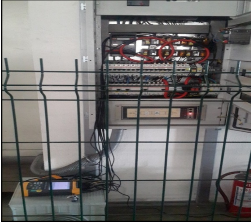
Şekil 4. Analizörün bağlantı şekli
