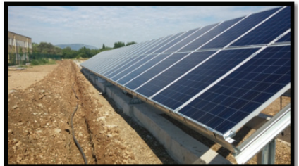
Panel ve Kablo montajı
