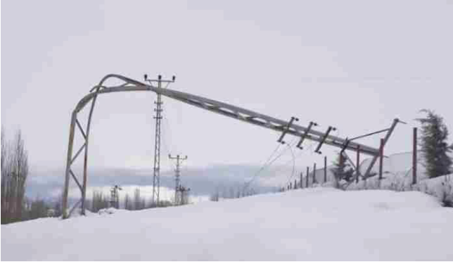
Şekil 3.2. Yoğun Kar Yüğü Sonrası Havai Hat Direklerinde ve Travers Sistemlerinde Meydana Gelen Yapısal Hasar ve Eğilme Durumu.
