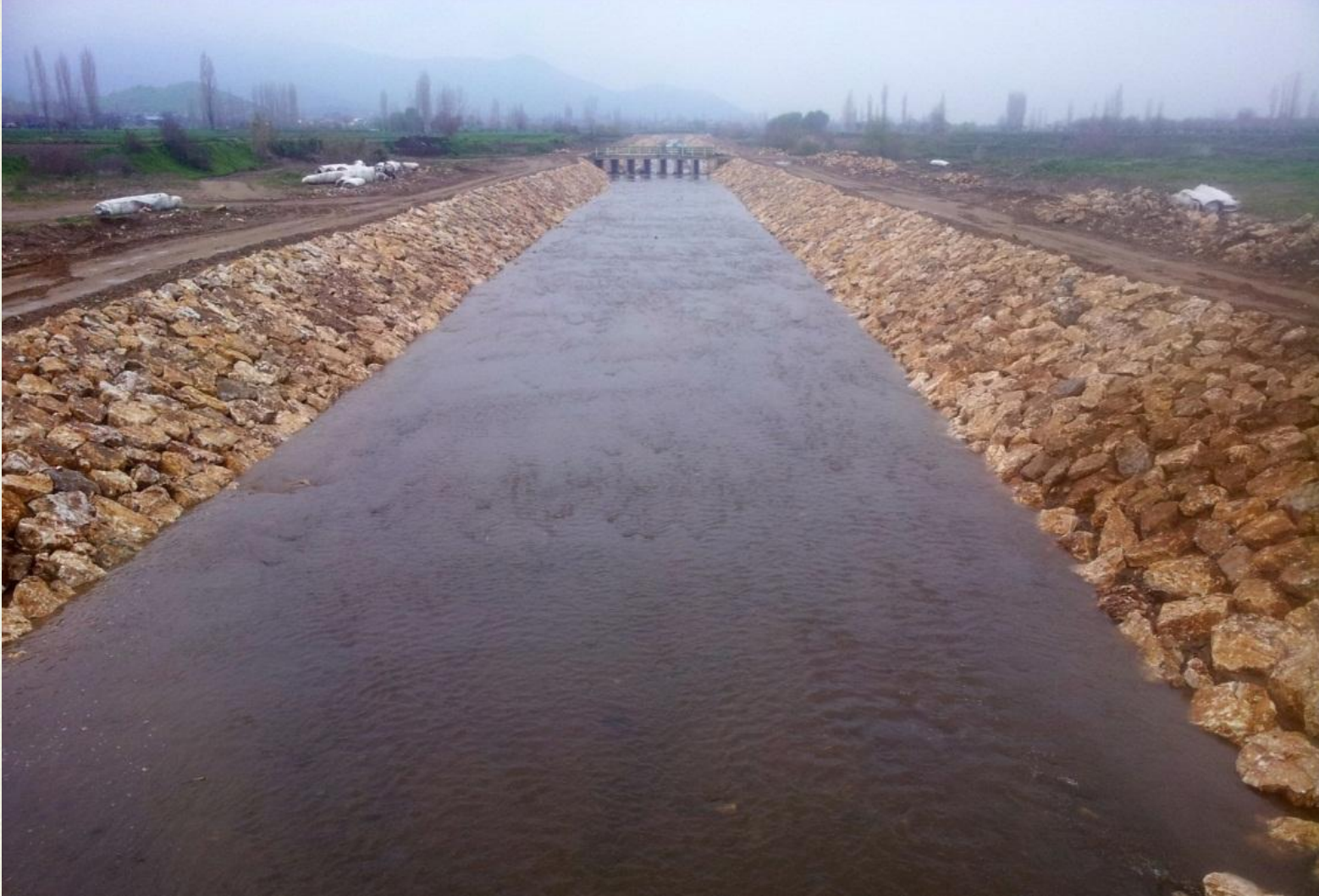
Şevlerde Geonetli Tahkimat Bitmiş Hali
