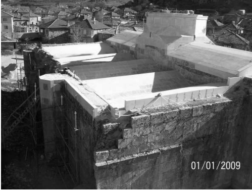
Şekil 2. Kervansarayın yeni çatı kaplaması
