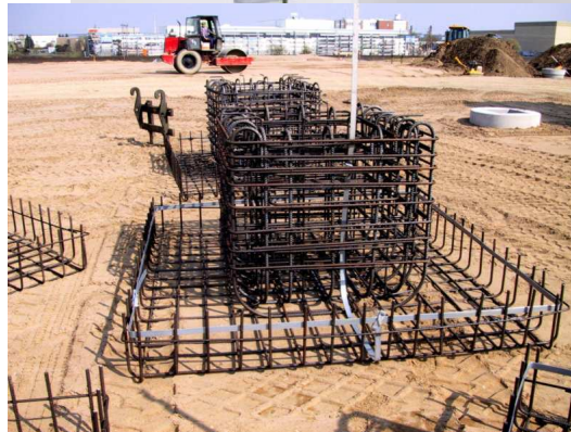
Çelik donatımlı temel topraklayıcının üstten görünüşü
