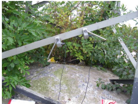
110 kV iletim direği
