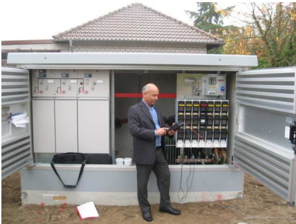
20 kV/ 0,4 kV Dağıtım transformatörü
