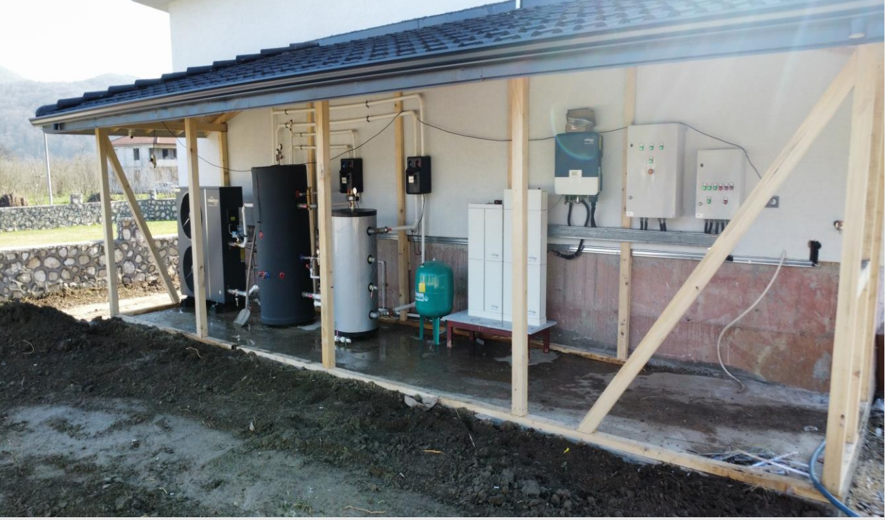
İlyas YAZICI Akyazı/SAKARYA Isı Pompası ve 14,62kWp/10kWe GES Sistemi
