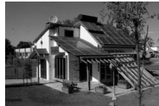
Resim 6 Güneş Evi'nin Fotovoltaikleri (Güneş Pilleri)
