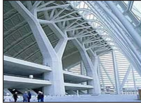
Resim 1. Beyaz Beton Yapıda Doğal Aydınlatma Uygulama Örneği [4]
