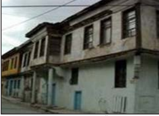
1. Bartın'da Ahşap Ev Örneği
