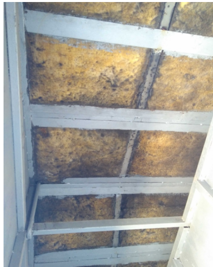
Saç KÖK Merkez AG BAR24 bölümü ve hiçbir yanık izi olmayan çatı izolasyonu
