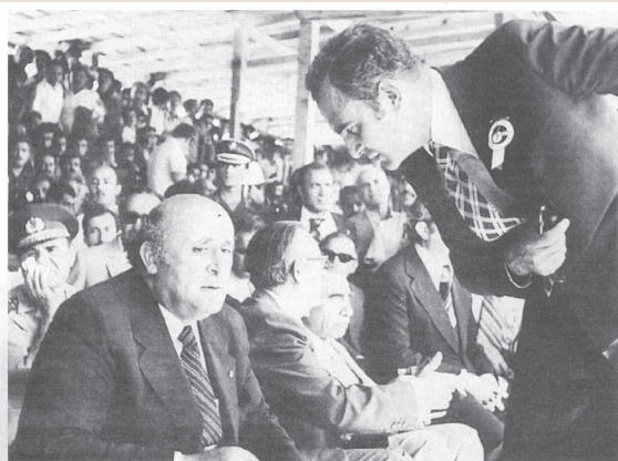
F. Behçet Yücel, Afşin-Elbistan Santrali'nin temel atma töreninde, dönemin Başbakanı Süleyman Demirel ile.
