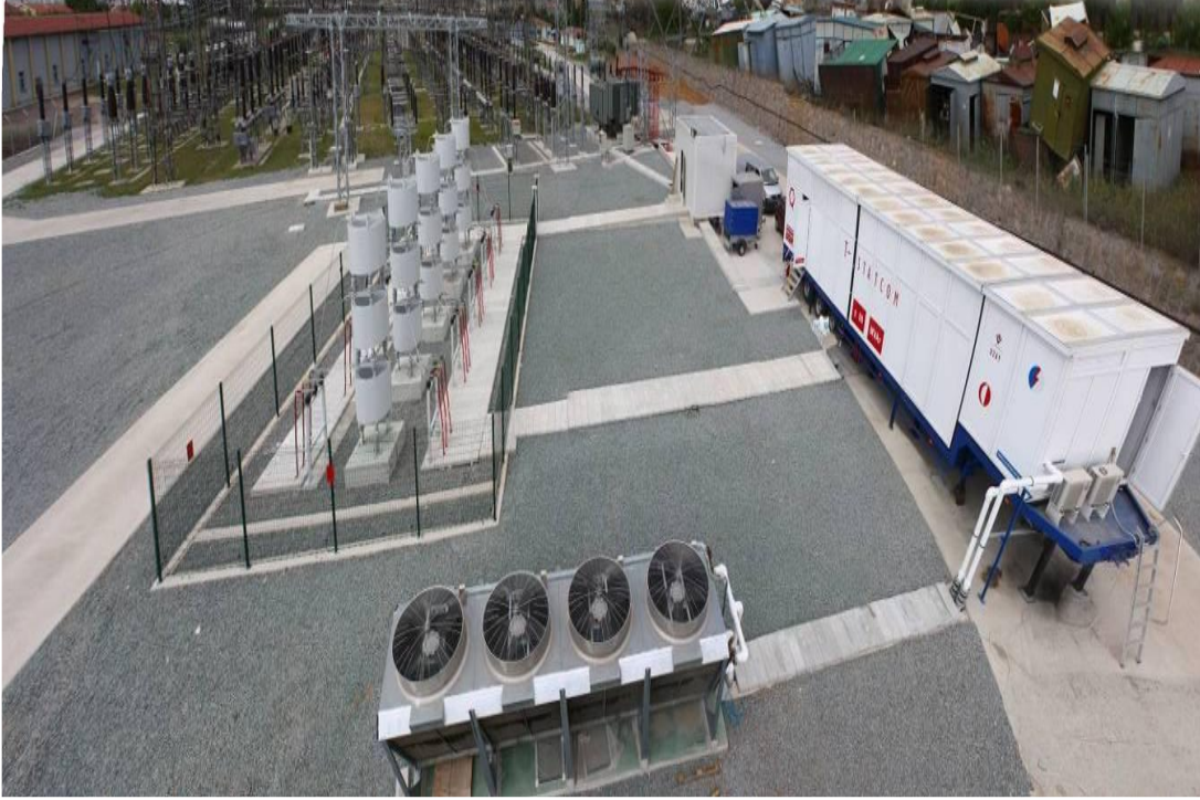
Şekil 55. Örnek bir STATCOM saha yerleşimi
