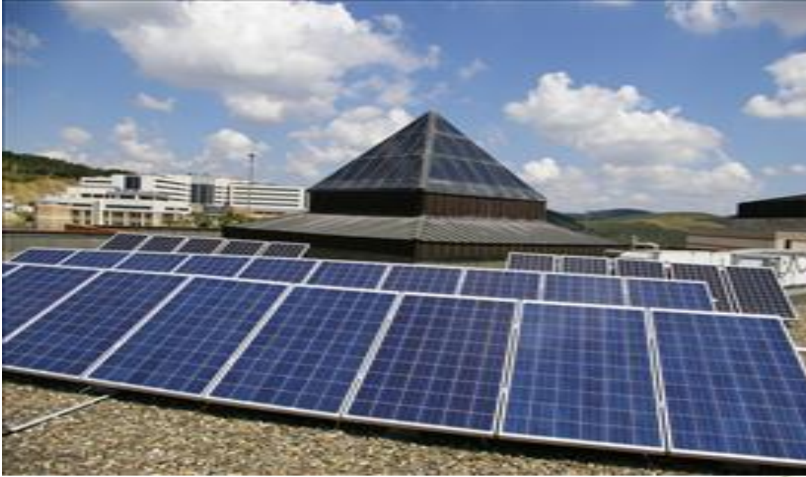
Şekil 3. Polikristal panel dizisi.
