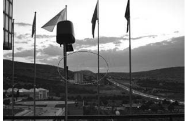
Şekil-3a. Turgut Özal Tıp Merkezi 1. katında hastanenin batı cephesinde bulunan radyo ve televizyon vericilerinin görüş açısında yerleştirilmiş olan istasyon.
