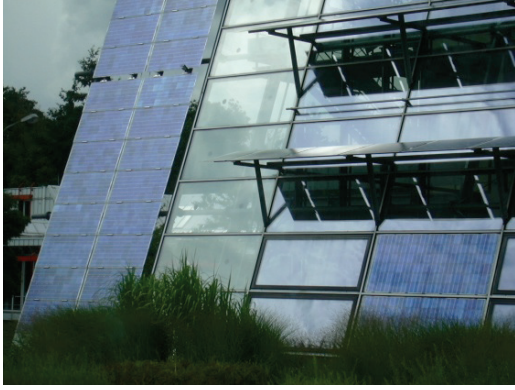
Şekil 7. Solar Fabrik Yönetim Binasında FV kullanım detayı, solda reklam panosu, sağda cephe panelleri ve gölgeleme elemanları [5]
