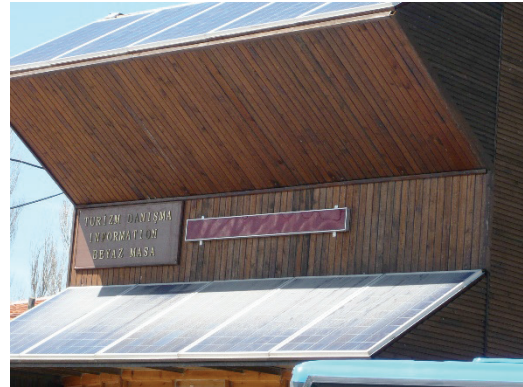
Şekil 18. Gökçeada Belediyesi'nin hizmet binasındaki FV panellerden detay [5]
