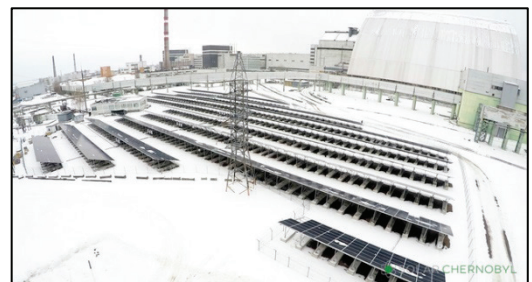
Şekil 1. Çernobil güneş elektrik santrali [1]
