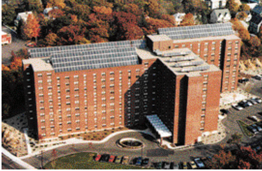
Şekil 3. Boston'daki çatısına FV paneller yerleştirilmiş çok katlı bina[4]
