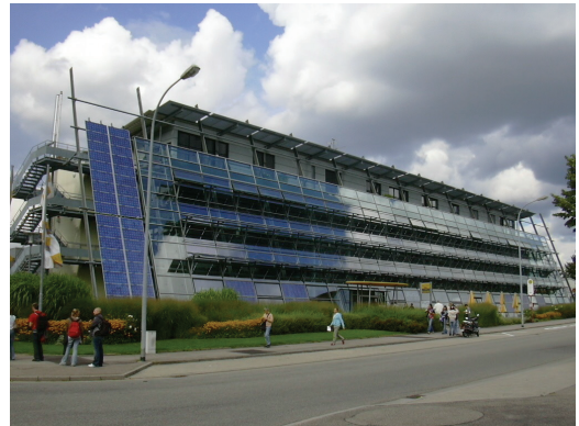
Şekil 6. Freiburg'daki Solar Fabrik Yönetim Binasının görünümü[5]
