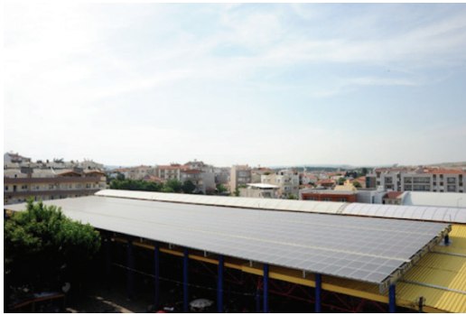
Şekil 19. Seferihisar Pazar yeri üst örtüsünün üstten görünüşü - FV paneller[22]
