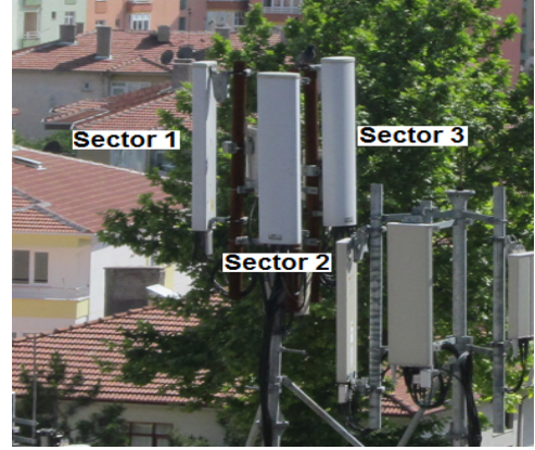
Şekil 1. Baz istasyonu sektör antenleri
