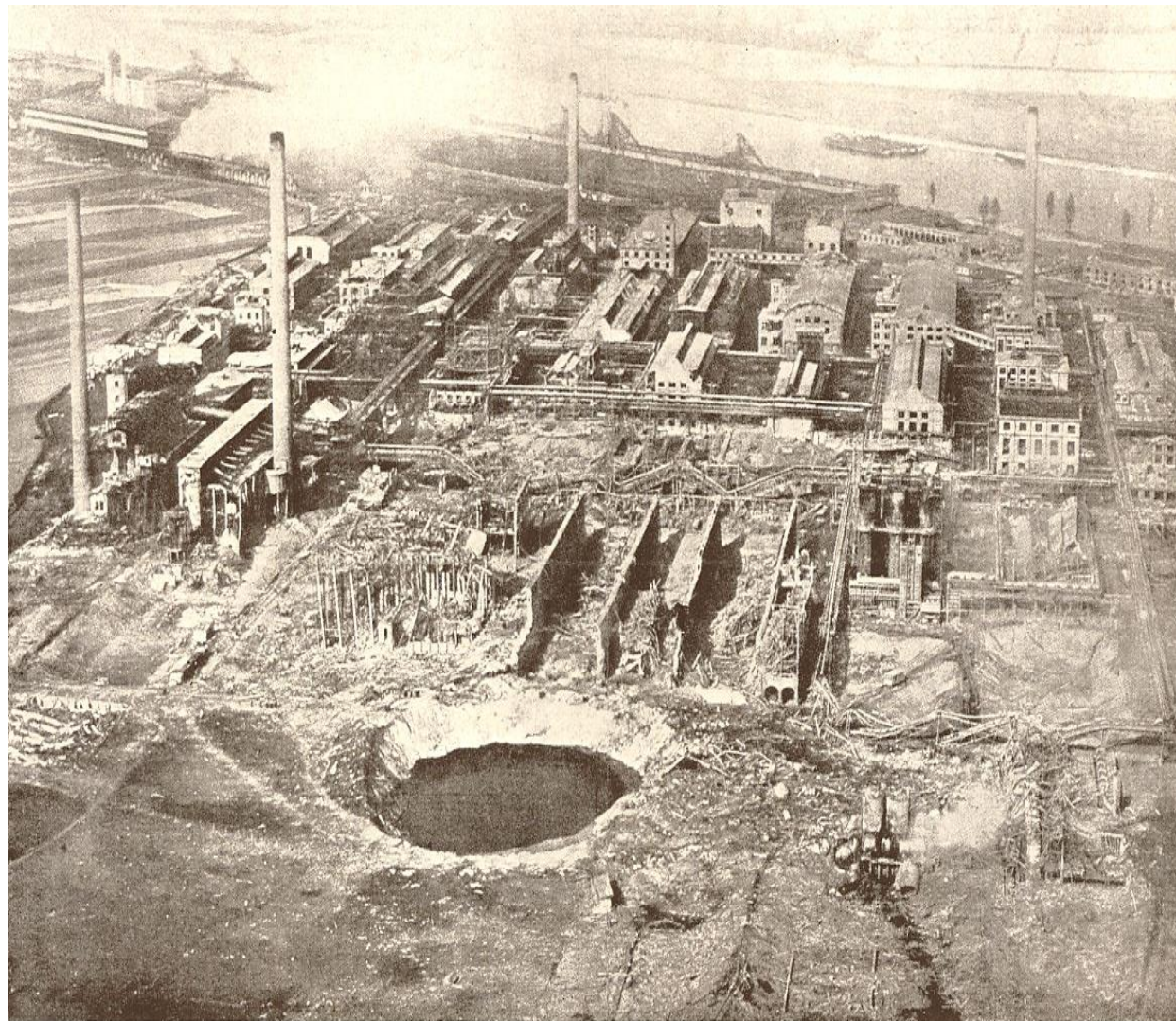
Der Herd der Explosion und der Umfang der Zerstörung im Oppauer Werk der Badischen Anilin- und Sodafabrik (B. A. S. F.). Im Vordergrunde der durch die Sprengwirkung entstandene ungeheure Trichter von 125 m Länge, 90 m Breite und 19 m Tiefe, über dem der Silo stand.
