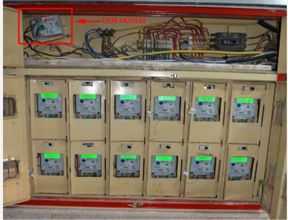
Resim 6 - 3. Trafo Bölgesindeki GSM modem ve abone sayaçları
