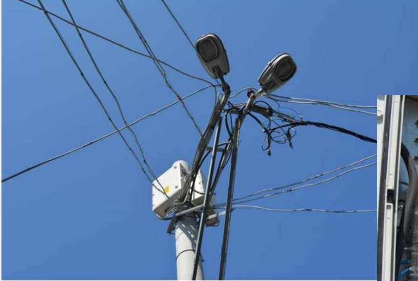
Resim 1 - 1. Trafo Bölgesindeki direk üstündeki panoya kurulmuş trifaze ve monofaze yatay sayaçlar ve yatay modem
