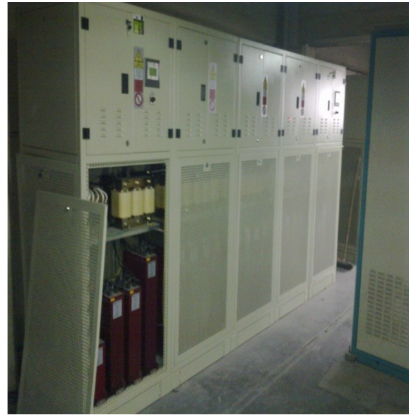
Şekil 3: 1.Fırına Ait Aktif Harmonik Filtreli Kompanzasyon
