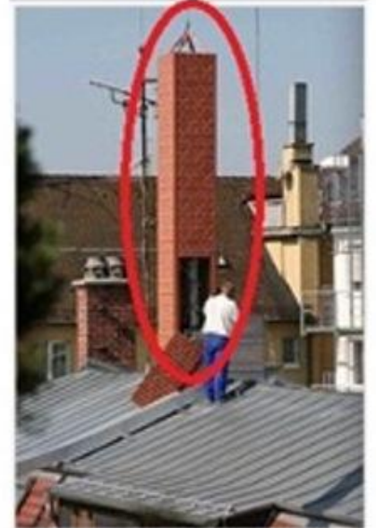
Ein als Schornstein getarnter Sendemast Baca görünümünde, Almanya
