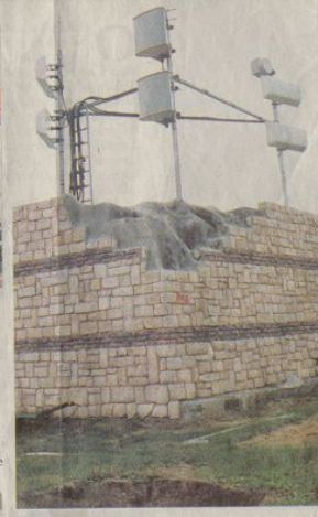
Zeytinburnu sahilindeki iki baz istasyonu minyatür kule ve sur şekline sokularak kamufle edildi.
