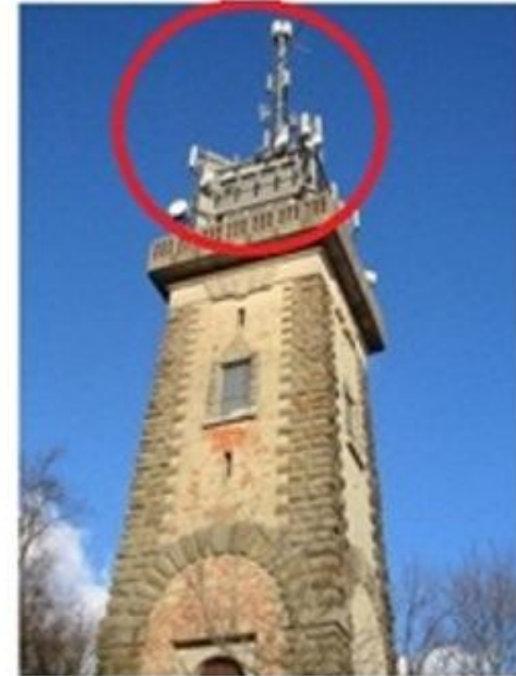
Ein als Schornstein getarnter Sendemast Baca görünümünde, Almanya
