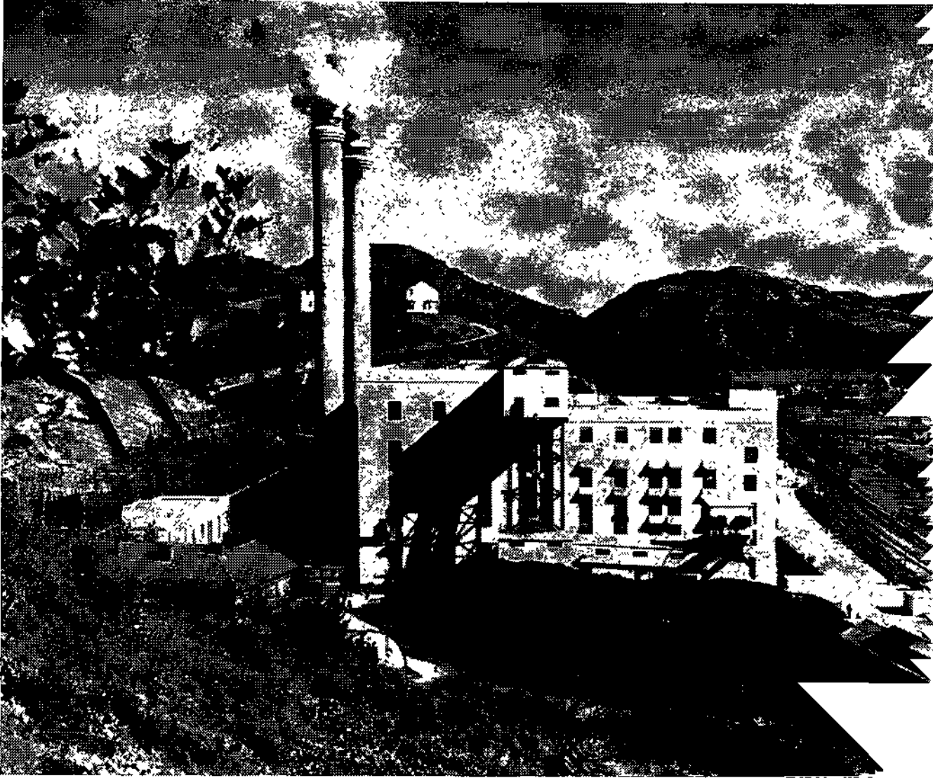
Çatalağzı Termik Santrali umumî görünüşü.
