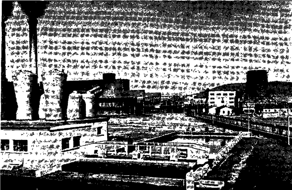
Tuuñbilek Termik Santralı su hazırlama tesisleri.
