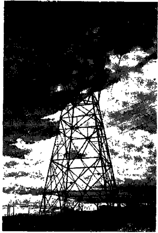
154 kV - Tek Aev:s İçtlerde bir durdurucu direk
