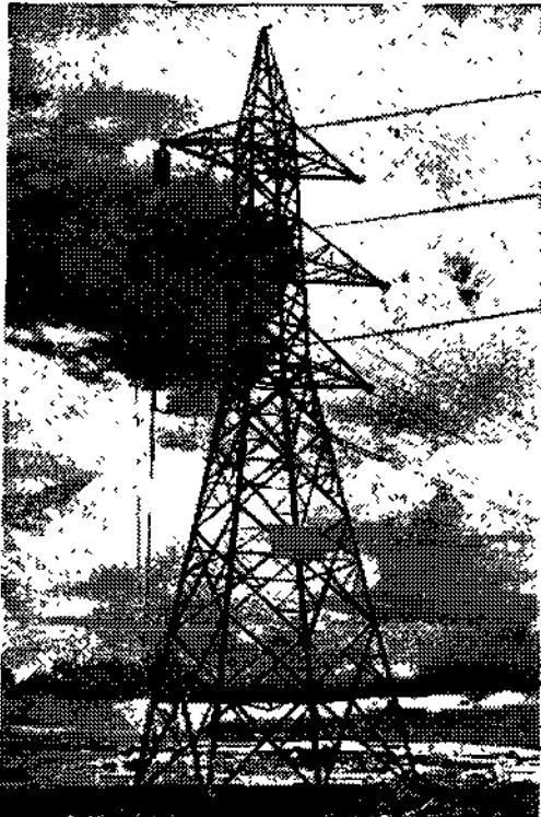
154 kV - Teki çekilmiş çift devre hatlarda bir durdurucu direk
