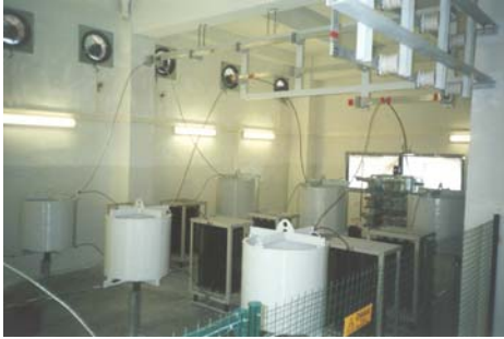
Şekil.4. Bara-1'e bağlı 5. ve 11. Harmonik Filtreleri
