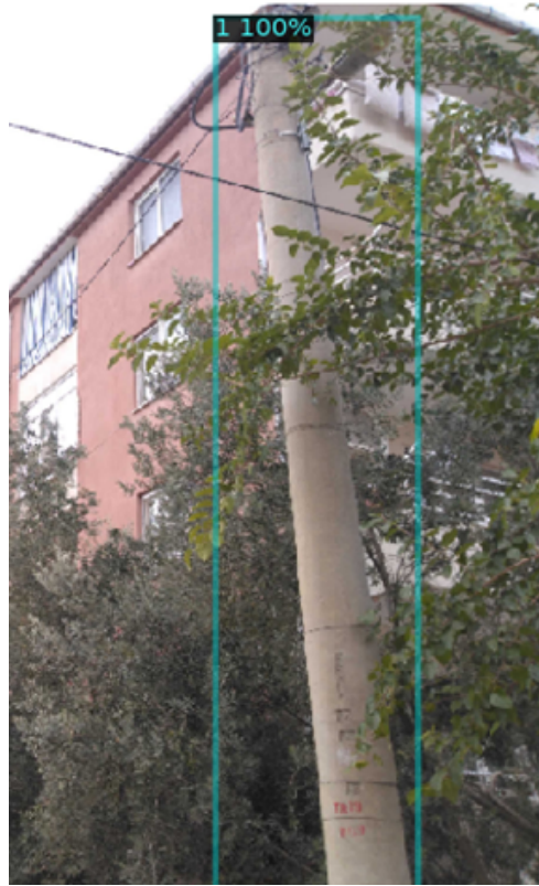
Şekil-8. Yazılım ile tespit edilmiş beton direk ve ağaç yakınlığı
