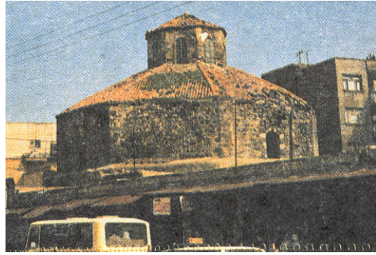
Şekil 17. Diyarbakır Melek Ahmet Paşa Hamamı.
