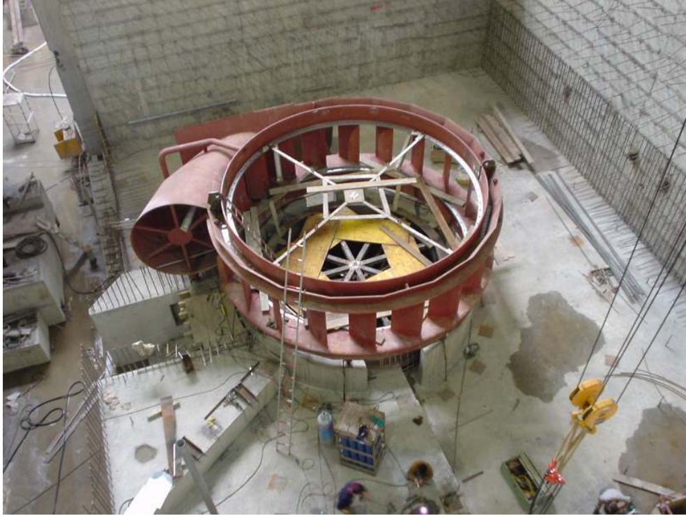
Resim 3: Yerli imalat örneği, 4,6m iç çapında, 57,5 MW Düşey Francis Hız Çemberi (Kaynak: Yazar'ın arşivi, Muratlı HES)
