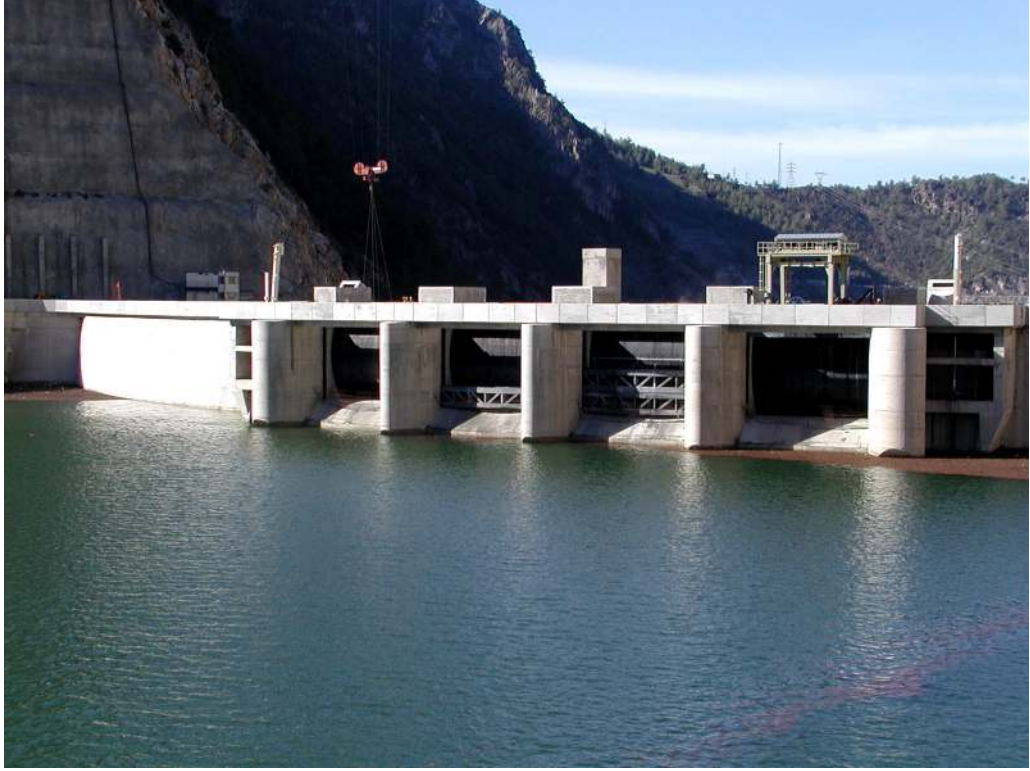
Resim 1: Yerli üretim örneği bir dolusavak görünüşü (Kaynak: Yazar'ın arşivi, Berke HES)
