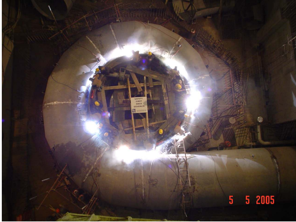
Resim 6: Yerli montaj örneği, 170 MW Düşey Francis Salyangoz kaynağı (Kaynak: Yazar'ın arşivi, Deriner HES)
