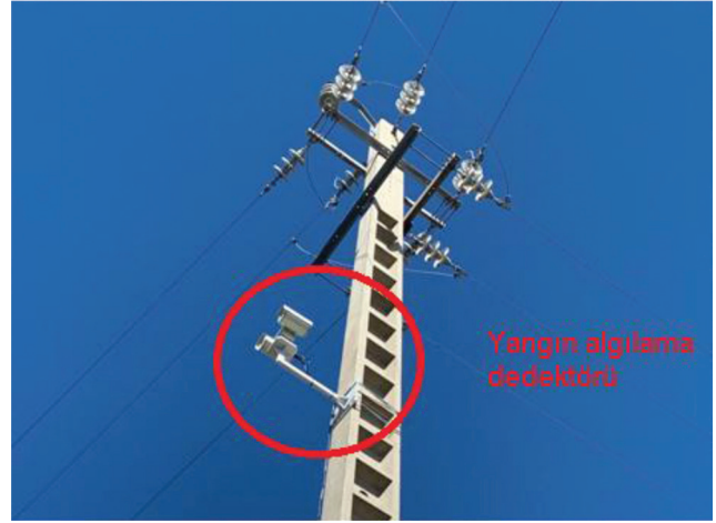
Fotoğraf 2. Çift Sensörlü Yangın Algılama ve Yüksek Çözünürlüklü (HD) İzleme Kameralarıyla Ormanlık Alan Takibi
